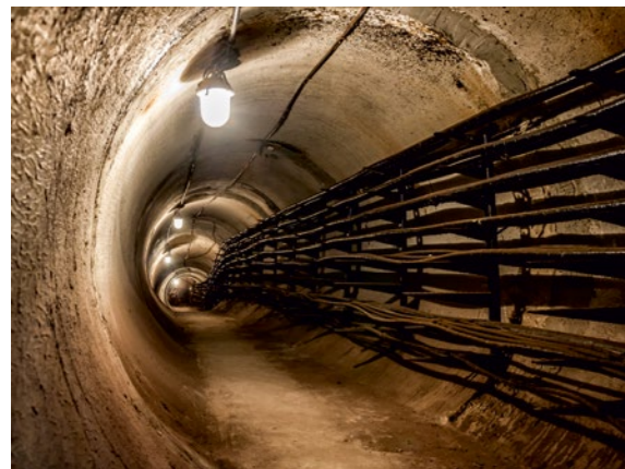
Решения для прокладки подземных коммуникаций
